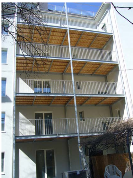
Hofseite mit den neuen grossen Balkonen
