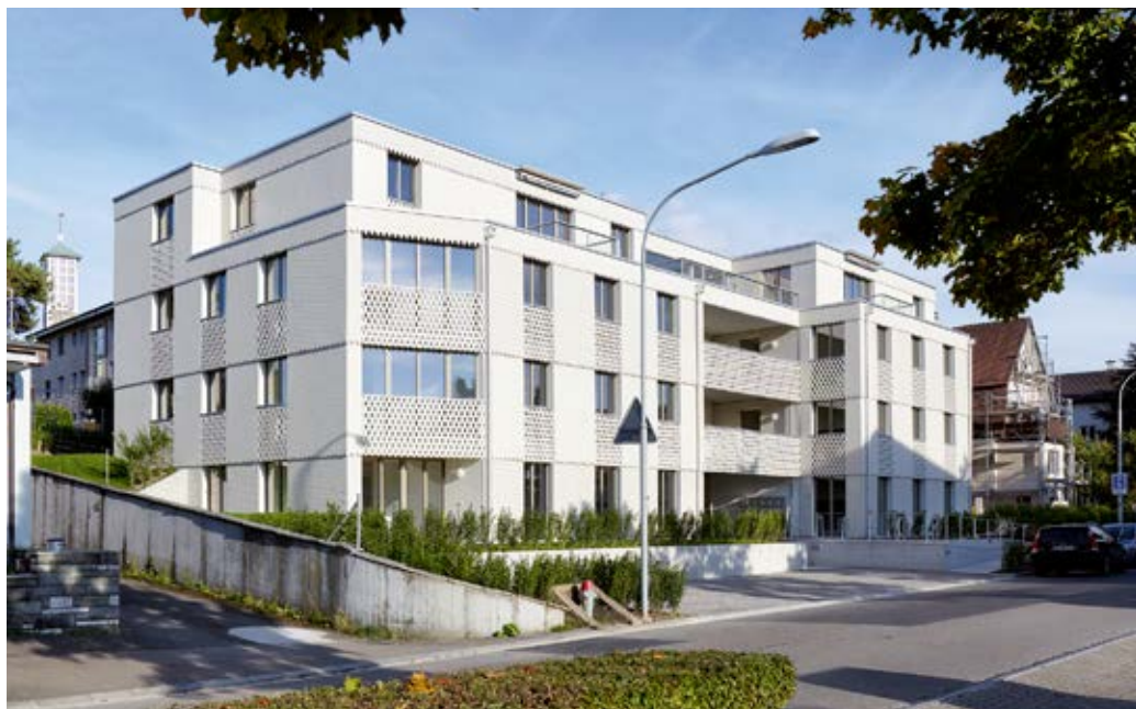
Blick auf die Eingangsseite: Das Treppenhaus in der Mitte verbindet die beiden Gebäudeteile und ist als Begegnungszone ausgelegt.
