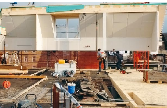
Die neuen Dachgeschosse wurden in Holzelementbauweise vorfabriziert und in einem einzigen Tag auf das Gebäude gesetzt.
