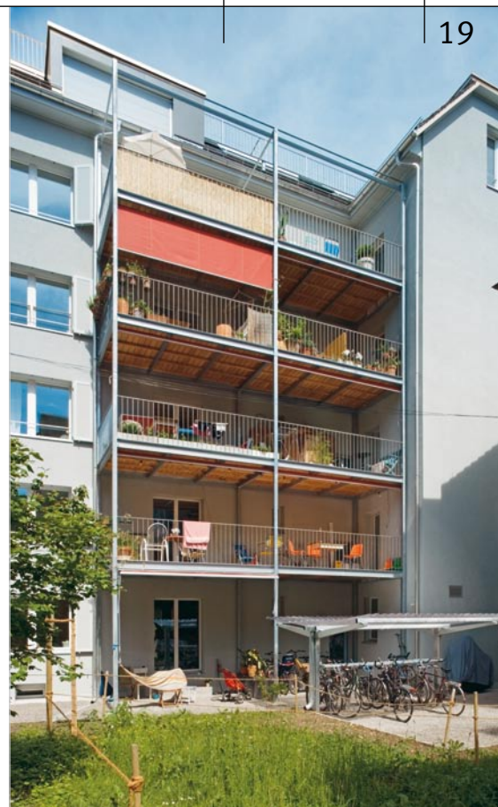
Die Wohnungen in den unteren Geschossen erhielten auf der Hofseite 20 Quadratmeter grosse neue Balkone.
